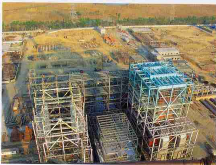
孟加拉电厂全景
